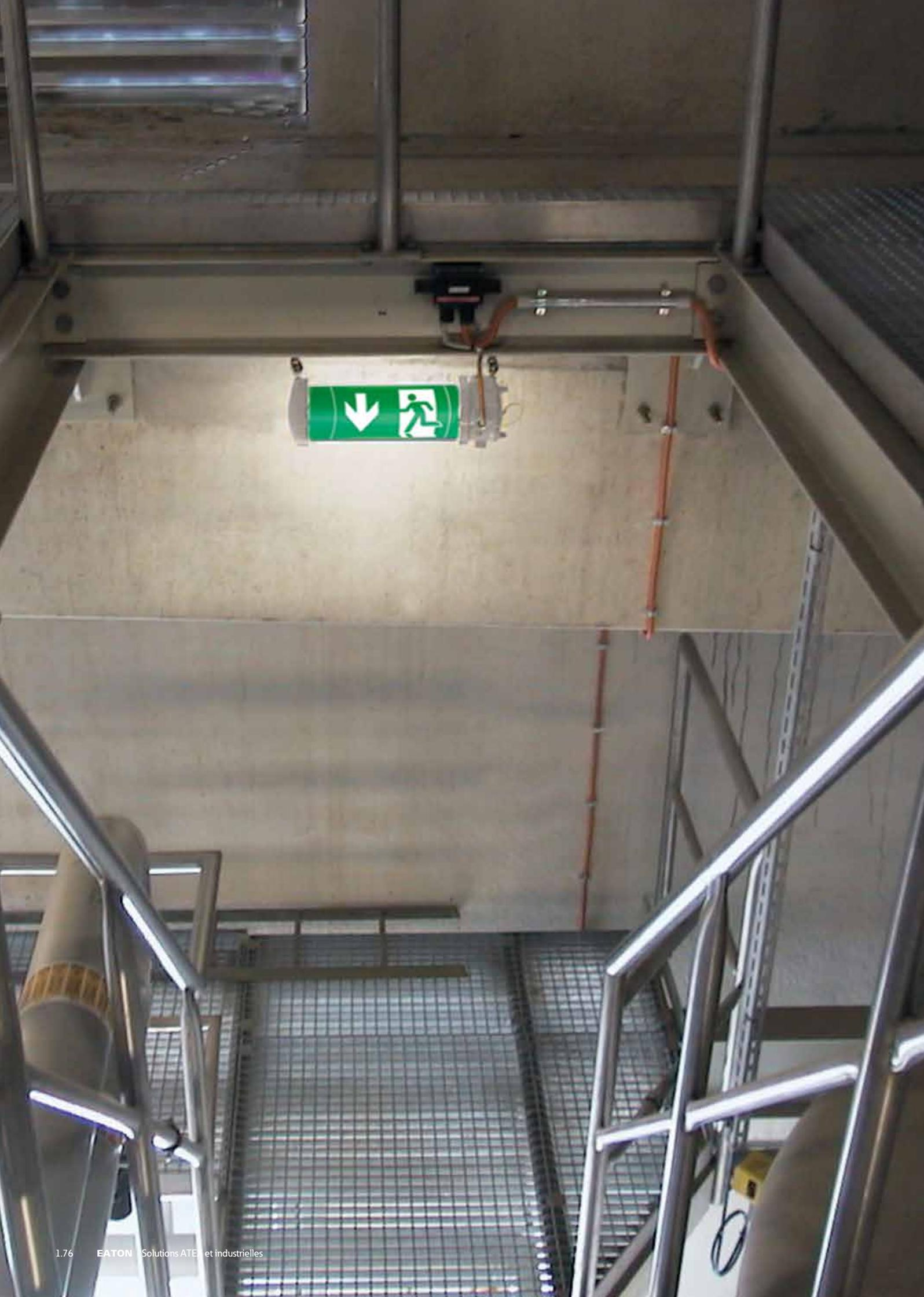
Solutions type B.A.E.S. (Bloc Autonome d'Éclairage de Sécurité), pour assurer l'éclairage d'évacuation et/ou l'éclairage d'ambiance dans vos établissements industriels, sans réseau secouru spécifique.
